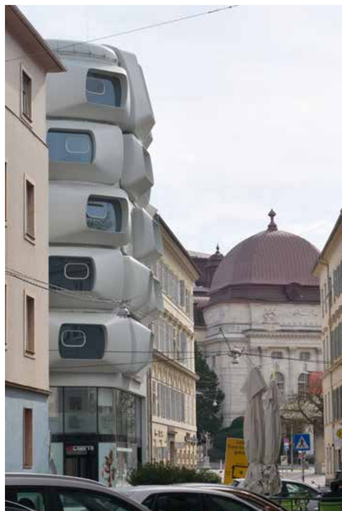
Altstadtzone I: Abriss des Kommodhauses und Neubau mit Blick zur Oper, Foto 2023
