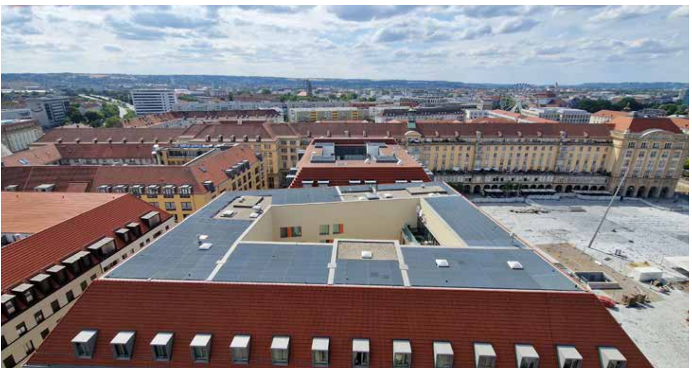
Baustelle Ferdinandplatz Dresden, Juli 2023 (Foto: Jakob Ehrlich, 2023)
