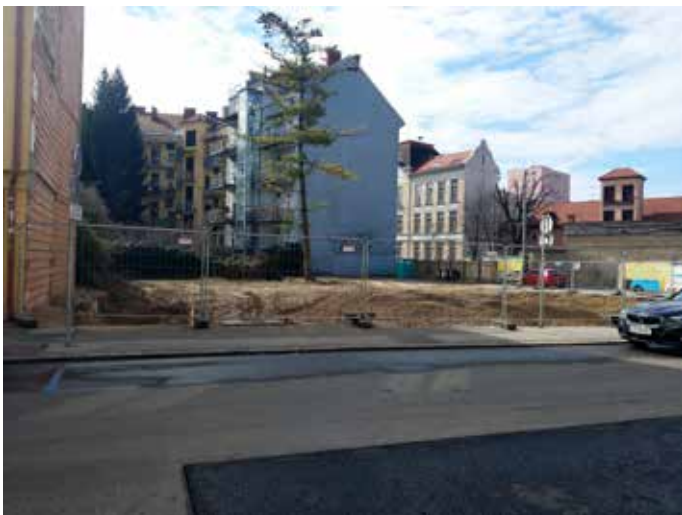
Altstadtzone III: Schörgelgasse 8 nun mir Baulücke
