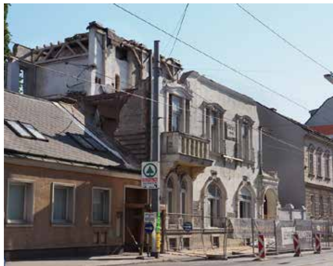
Abb. 1: Abriss des Hopfhauses in der Donaueferstraße 241 (Wien, 22. Bezirk) im Jahr 2014 (Foto: Erich J. Schimek)
