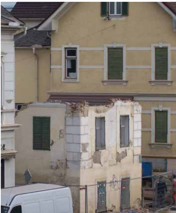
Abriss des ältesten Hauses von St. Peter, Foto 13.1.2015 St.-Peter-Hauptstraße 71
