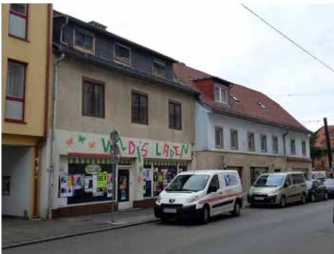
Altstadtzone III: Dietrichsteinplatz/Schörgelgasse 8 vor dem Abriss
